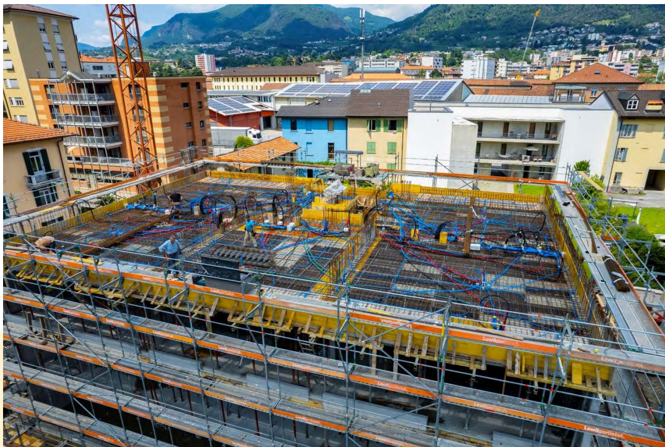
Realizzazione del 4. solaio.
