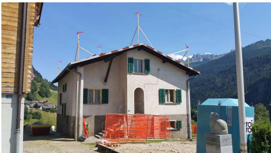
Un edificio residenziale in loc. Airolo (TI) doveva essere ampliato, rinnovato ed essere reso finalmente efficiente dal punto di vista del bilancio energetico. Per limitare al massimo l'influenza sulla porzione esistente dell'edificio si è optato per un sistema costruttivo a secco con struttura leggera in legno.
