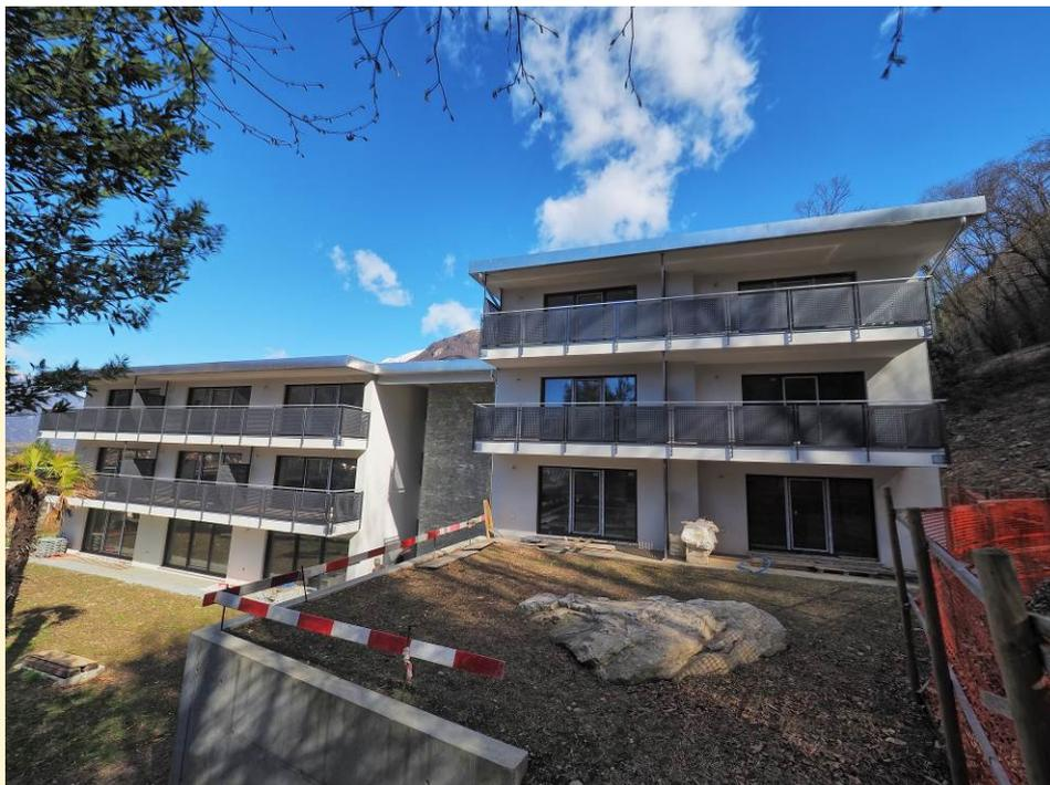
Le pareti perimetrali sono in sistema costruttivo tipo "platform - frame" di 14 cm di spessore. I solai a travetti di altezza variabile tra i 20 e i 24 cm ad interasse variabile. La resistenza al fuoco richiesta è R30.
