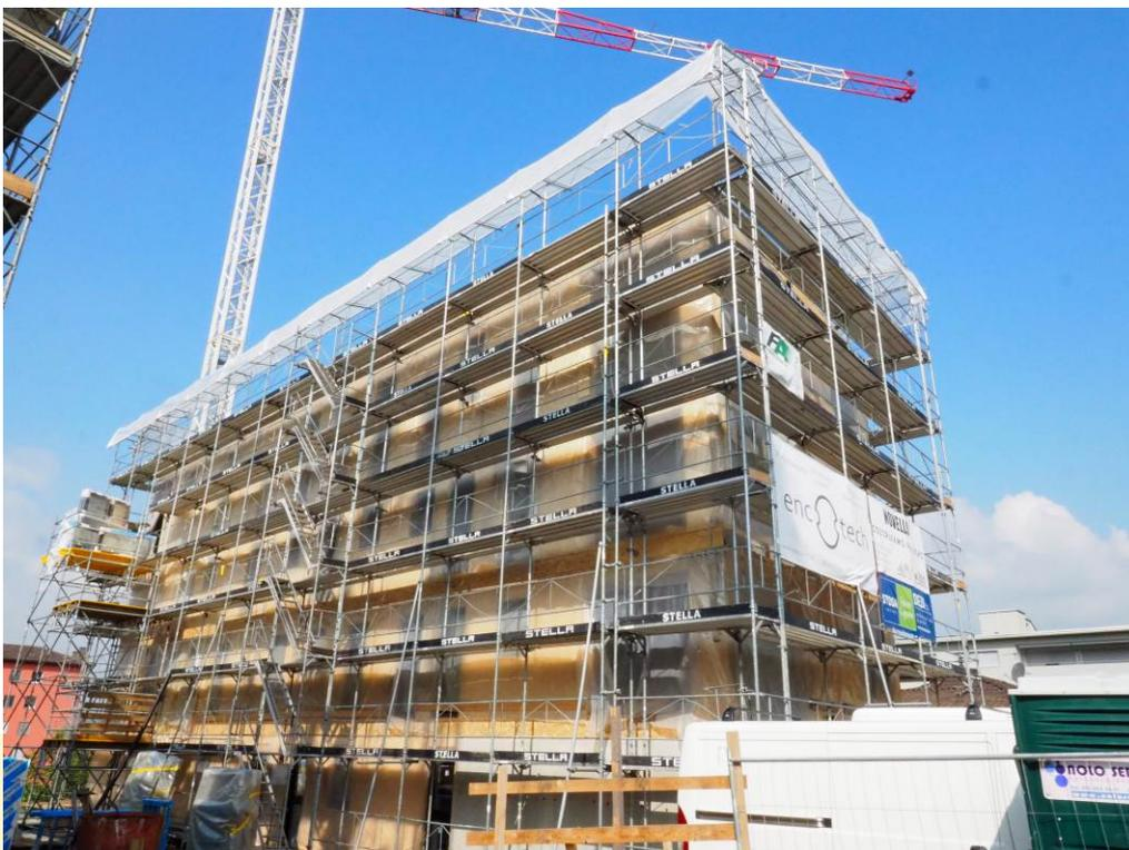
Le strutture interrate sono in cemento armato. La struttura fuori-terra è costituita da pareti a telaio “platform-frame” e da solai in
