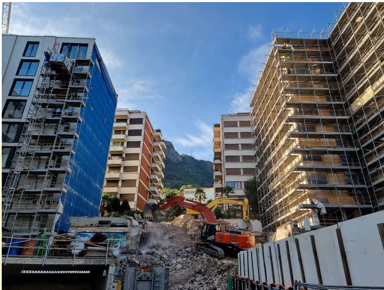
Demolizione dell'edificio precedente. Il terzo palazzo sorgerà in mezzo ai due già realizzati.
